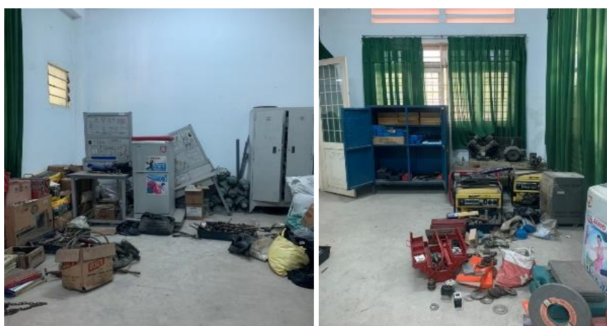
Hình 4: Thực trạng nhà kho
